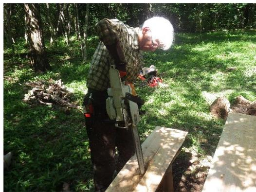
角を削り、ベンチの窪みの水抜き穴を作る。
