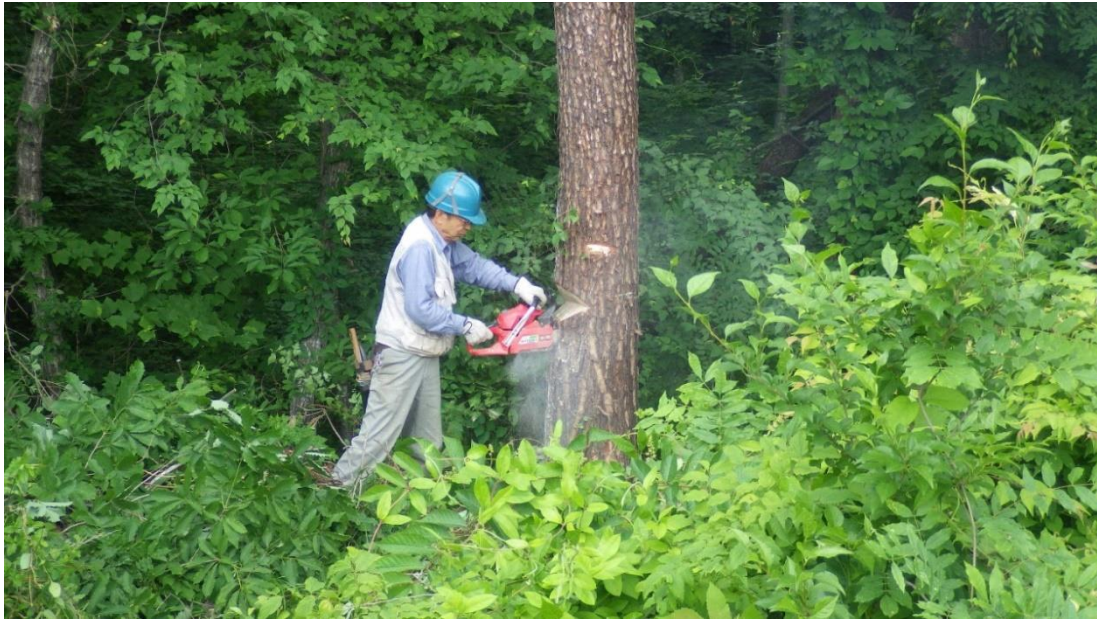
写真2 枯れた高木アカマツの伐倒 (その1)
